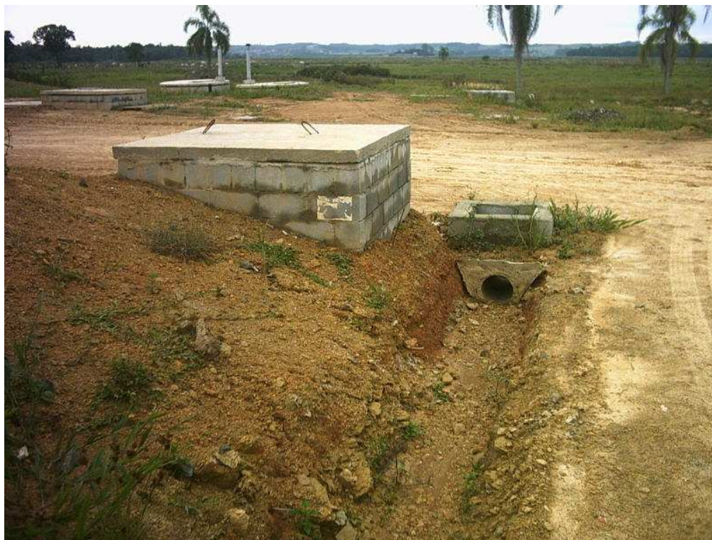
FIGURA 15 - Drenagem de águas pluviais (Fonte: MANGILI, 2006).
