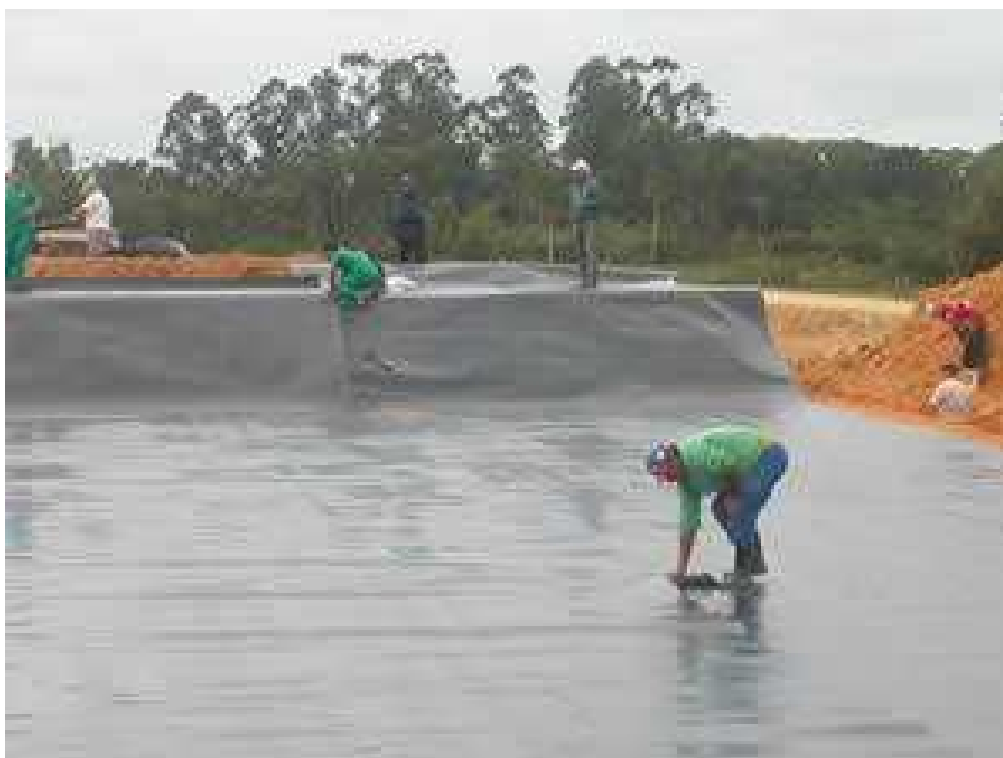
FIGURA 12 – Instalação manta de PEAD para a impermeabilização da base do aterro (Fonte: SANTEC, 2005).
