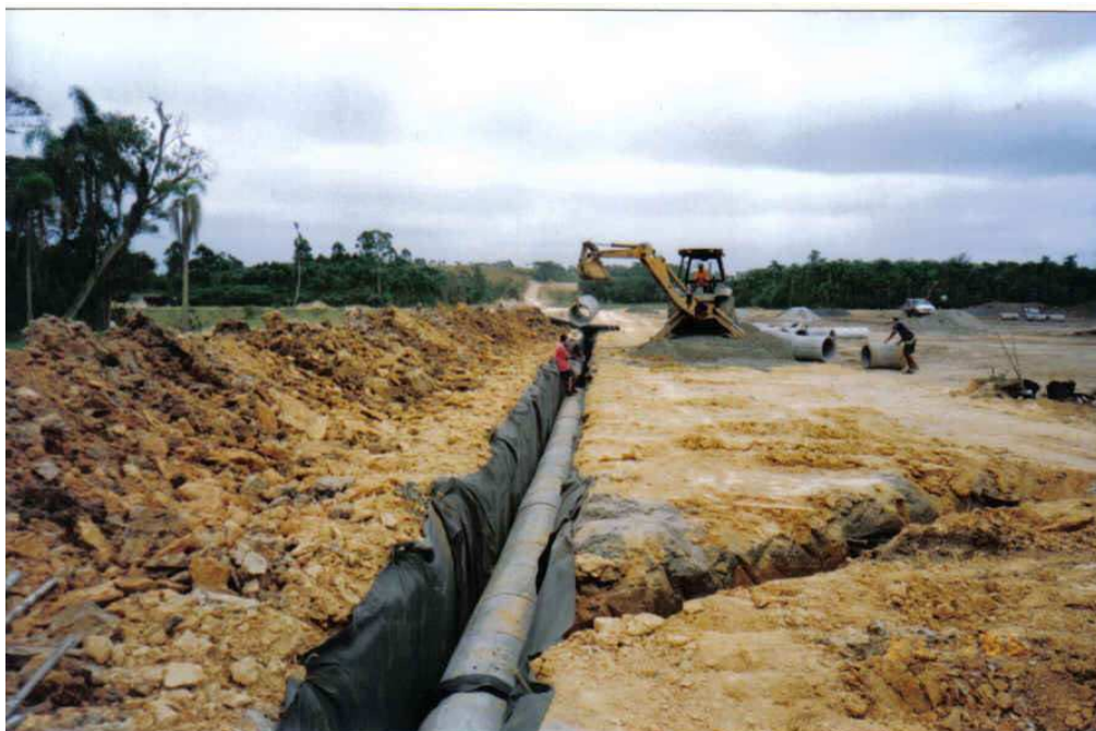
FIGURA 14 – Instalação dos drenos capa captação das águas subterrâneas (Fonte: SANTEC, 2005).
