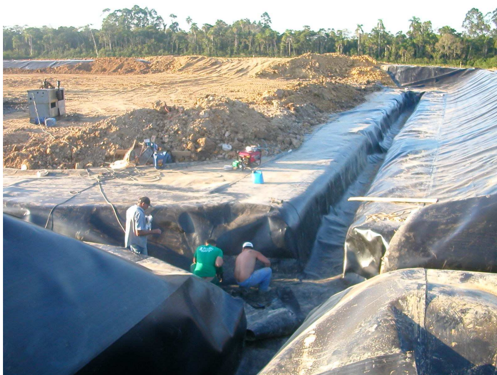
FIGURA 16 - Impermeabilização do aterro (Fonte: SANTEC, 2005).
