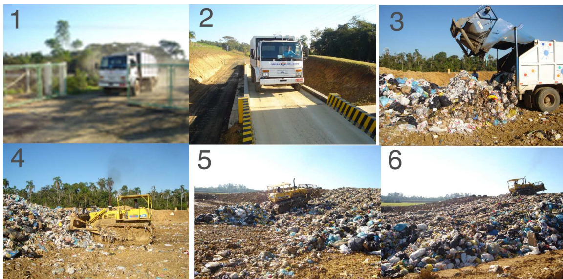
FIGURA 18 – Etapas da disposição final dos resíduos sólidos no aterro sanitário (Fonte: MANGILI, 2006)
